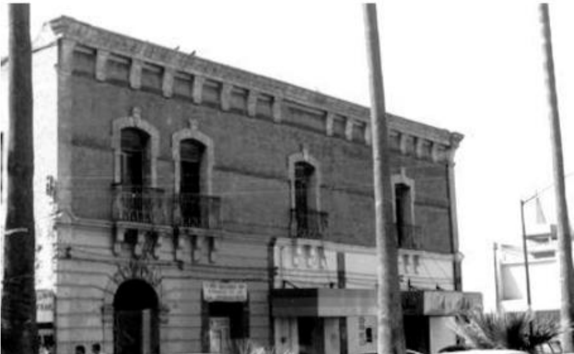
Av. Morelos y calle Zaragoza (1970)
